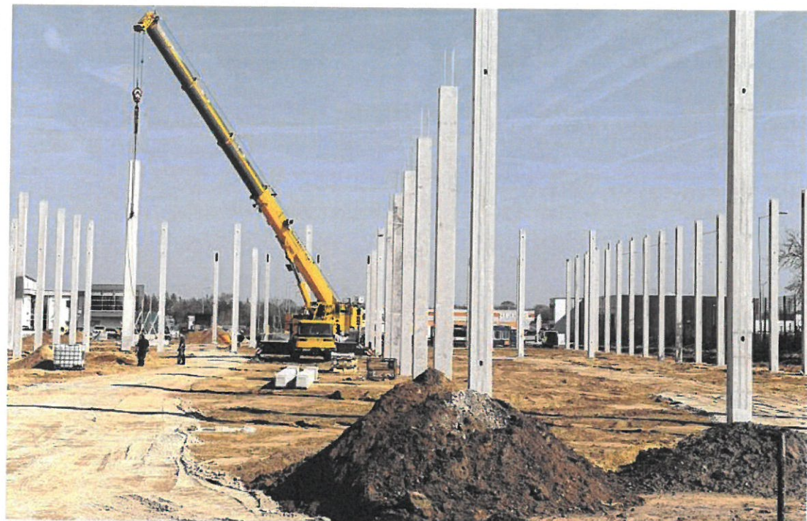
Auf dem WEG-Gelände in Handewitt entstehen derzeit eine neue Lagerhalle und ein Erweiterungsbau für eine Spedition.
